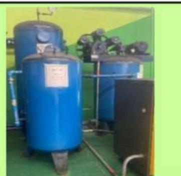
**18. TANQUES PARA AIRE COMPRIMIDO**
